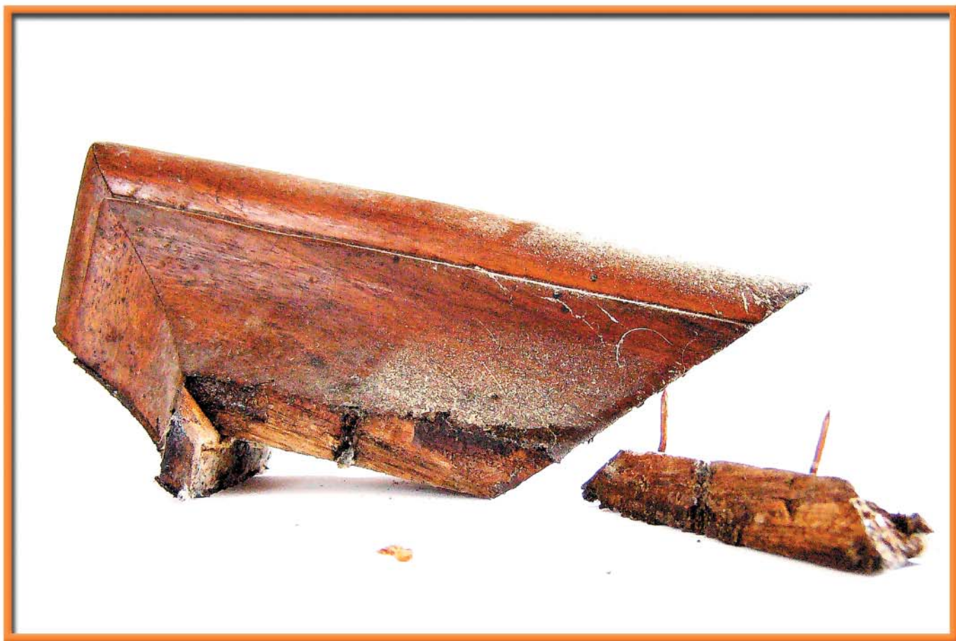
Horní soklová římsa v minulosti rozlomená a zpětně uchycená hřeby.
