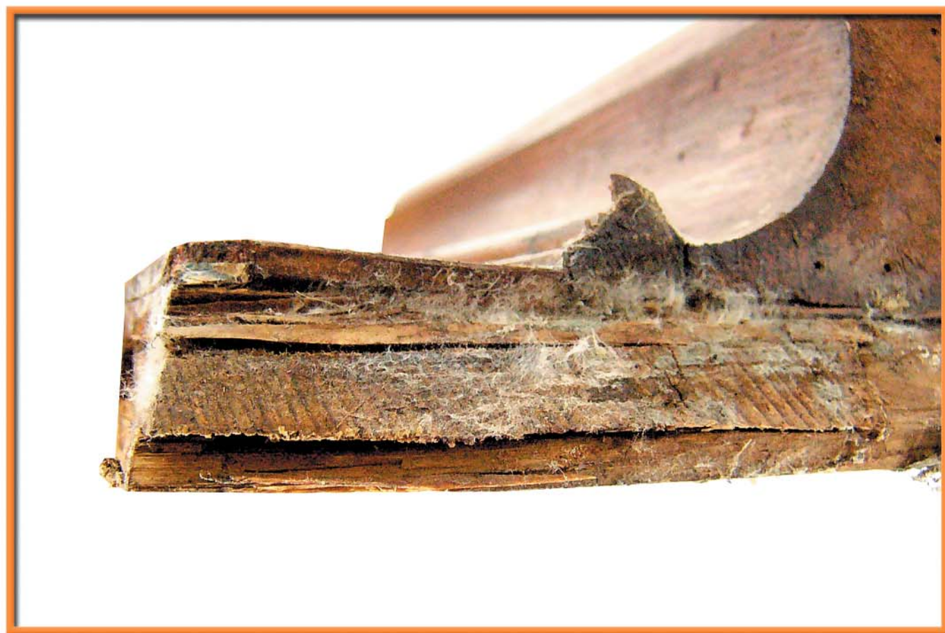
Horní soklová římsa v minulosti nadvakrát přeříznutá.
